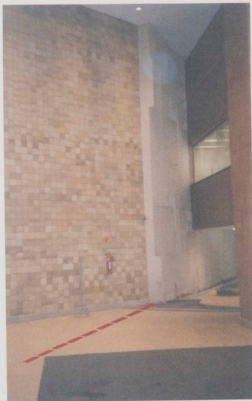
FOTO 01- PAINEL A SER COMPLETADO
